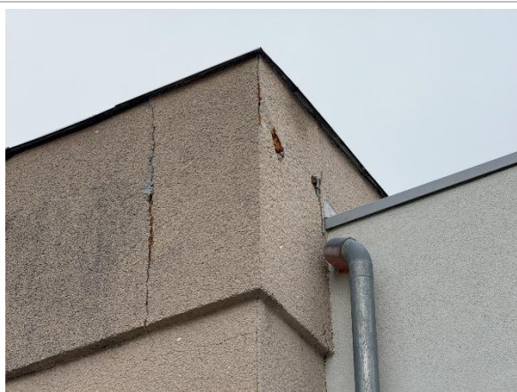
Obr. 4 Poruchy u atikových panelů v rozích objektu
