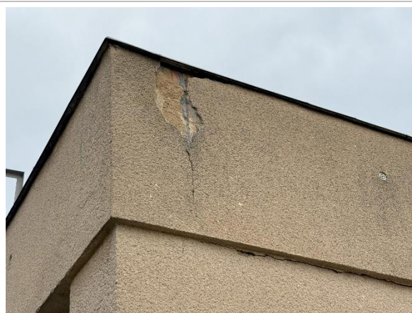
Obr. 4 Poruchy u atikových panelů v rozích objektu
