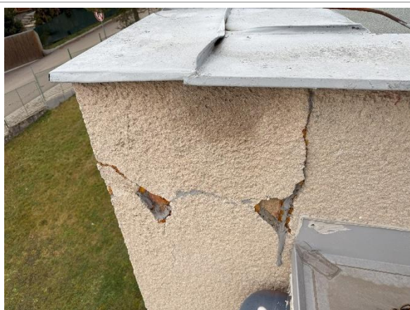
Obr. 5 Poruchy u atikových panelů v rozích objektu
