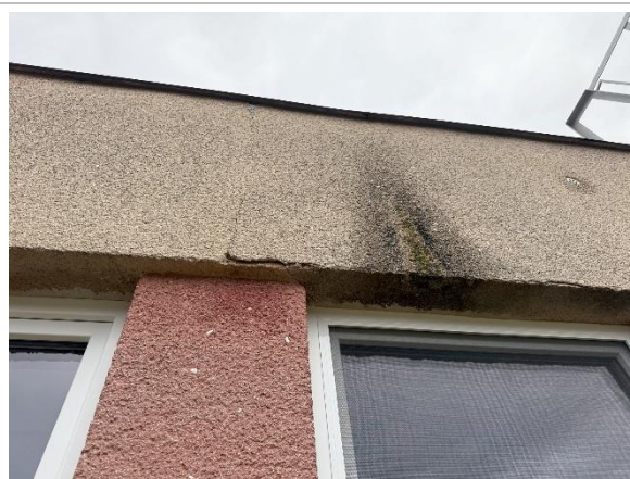
Obr. 6 Trhliny mezi atikovými panely, zatékání
