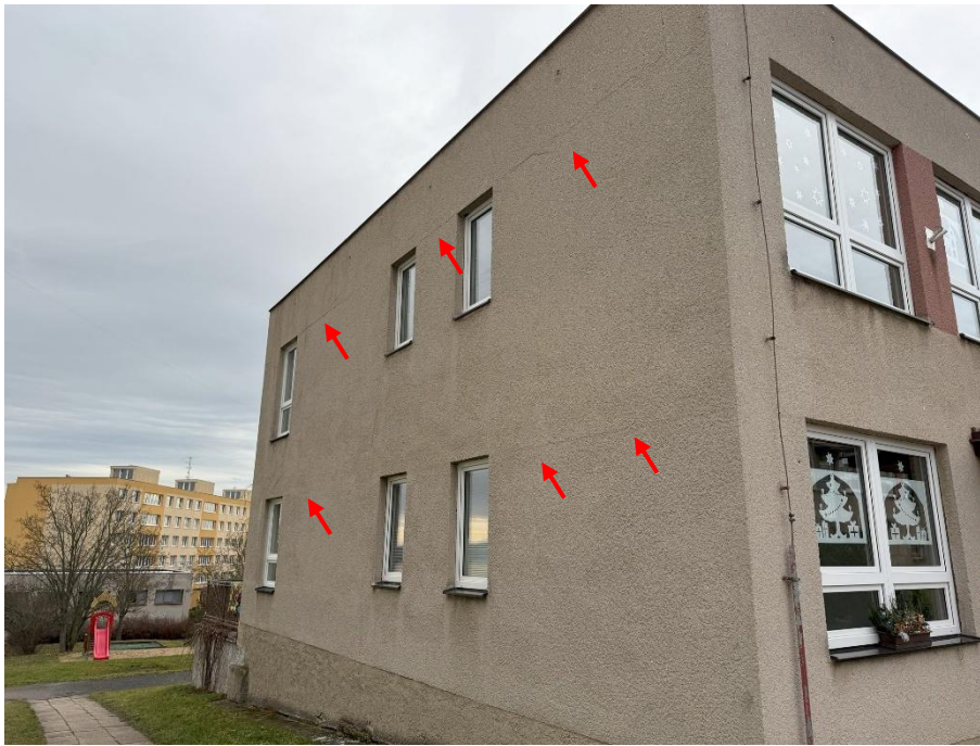
Obr. 9 Trhliny štítové stěny – prokreslené atikové a parapetní panely
